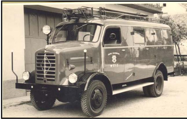
**Leichtes Löschgruppenfahrzeug „LLFA“
